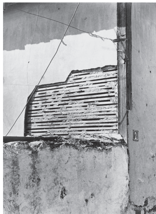
Εικ. 21. Άνω Πόλη Θεσσαλονίκης. Πηχάκια καρφωμένα μέσα-έξω στον ξύλινο σκελετό (Μπαγδατότοιχος), συσχέτιση με εικ. 20.
