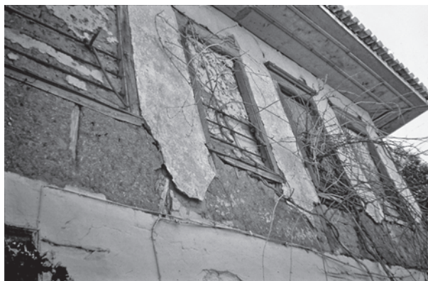
Εικ. 121.1. Τύρναβος. Ωμόπλινθη κατοικία συμμετρικού τύπου με σαχνισί στην πρόσοψη. α. Κάτοψη ισόγειου. β. Κάτοψη ορόφου. γ. Άποψη από τον δρόμο (φωτ. 1978). δ. Λεπτομέρεια τσατμά.
