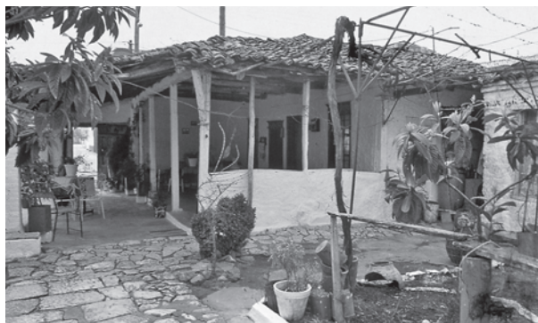
Εικ. 121.2. Τύρναβος. Ωμόπλινθη ισόγεια κατοικία με διαβατικό.
