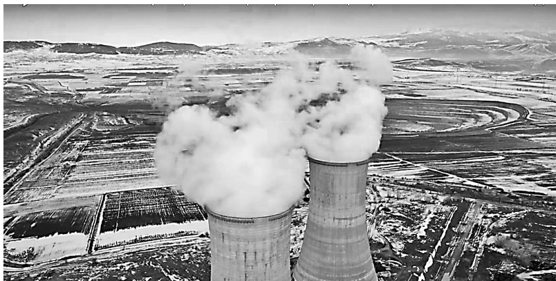
Εικ 3. Περιοχή λιγνιτικού κέντρου ΔΕΗ Δυτικής Μακεδονίας.
