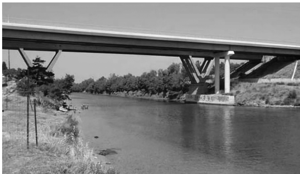
Σχήμα 2.1.5. Άποψη της νέας σύμμικτης γέφυρας στη διώρυγα της Νέας Ποτίδαιας Χαλκιδικής.
