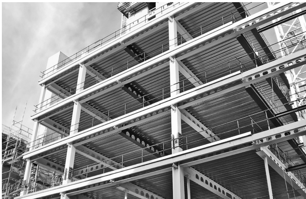
Σχήμα 2.1.4. Άποψη από τη φάση ανέγερσης σύμμικτου πολυώροφου κτιρίου.
