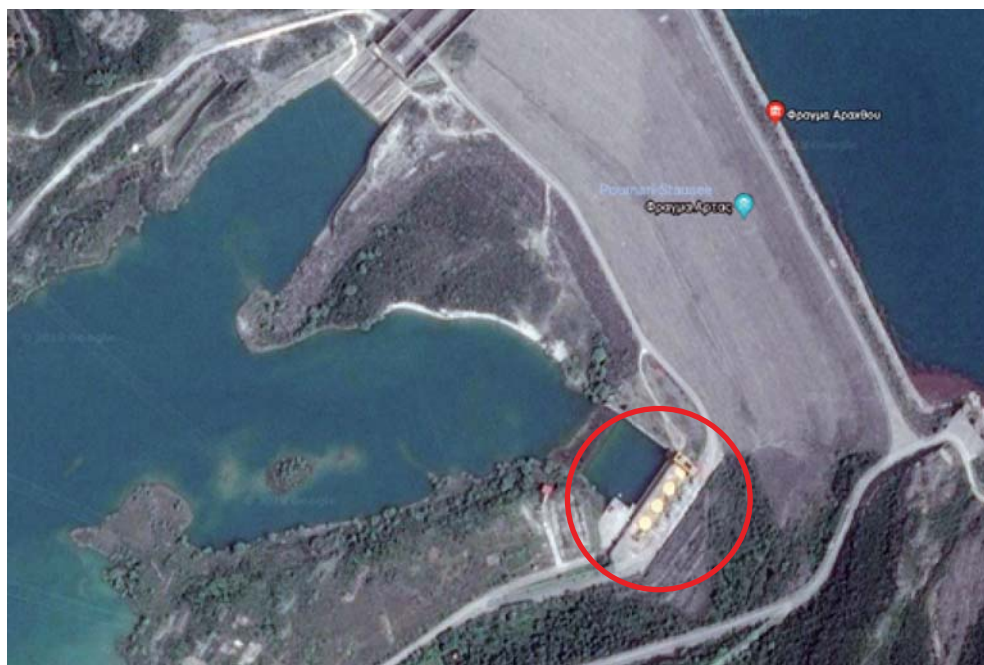
Φωτ. 1.3. Ο Υδροηλεκτρικός Σταθμός Πουρναρίου της ΔΕΗ.
