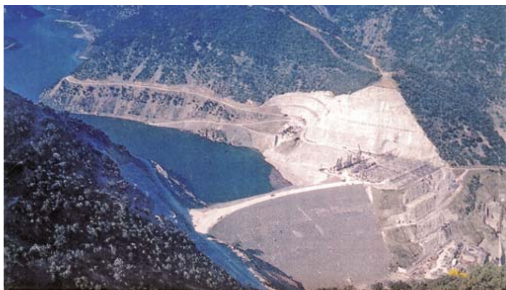
Φωτ. 5.5.44. Το φράγμα της Σφηκιάς και ένα τμήμα του ταμιευτήρα. Το έργο είναι αντιστρεπτής λειτουργίας (pumped storage), σε συνδυασμό με τον κατάντι ταμιευτήρα των Ασωμάτων, από τον οποίο αντλεί νερό τη νύχτα, που η τιμή της kwh είναι χαμηλή και παράγει ενέργεια την ημέρα, που η τιμή της είναι υψηλότερη.
