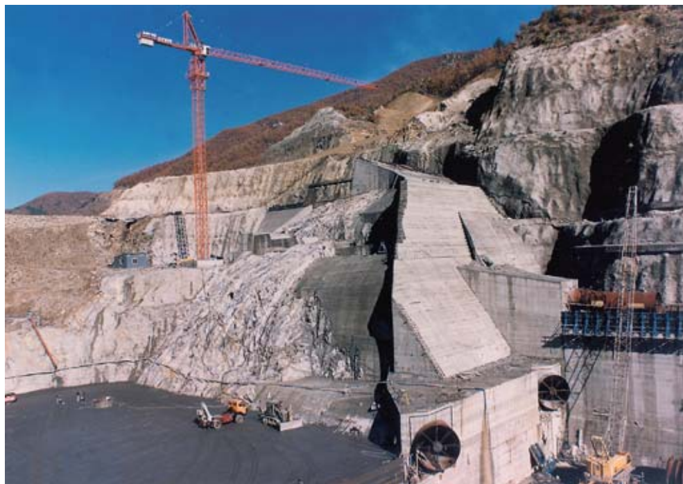
Φωτ. 7.11. Μια φάση από την κατασκευή του φράγματος της Πλατανόβρυσης. Δεξιά φαίνεται το τμήμα της κατάντι παρειάς, οι διερχόμενοι μέσα από το σώμα του φράγματος αγωγοί μεταφοράς και οι διαμορφώσεις των ανωμαλιών του βραχώδους πρσανούς με RCC.
