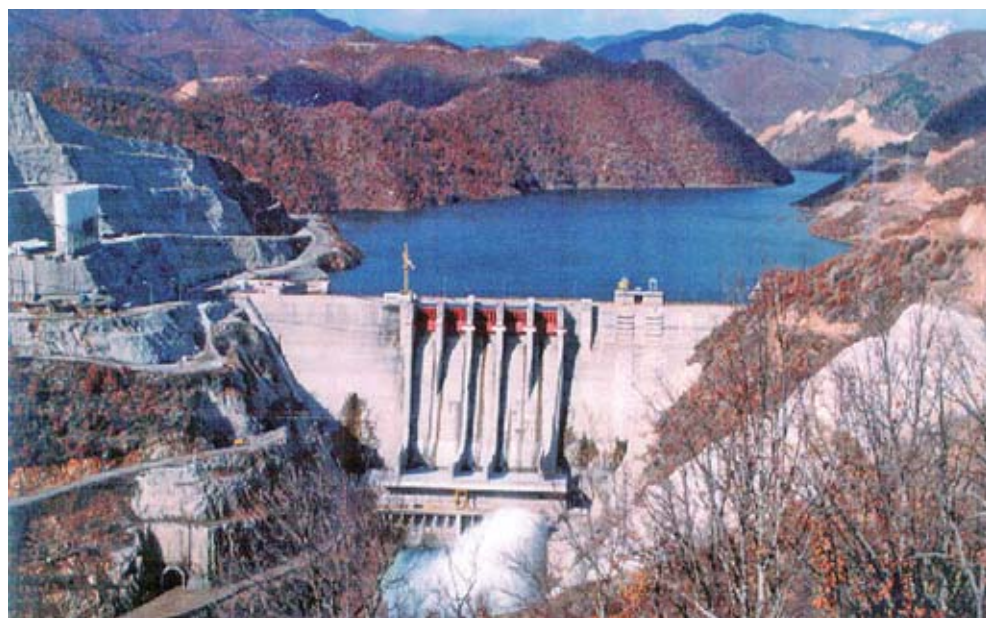
Φωτ. 1.5. Ο υδροηλεκτρικός Σταθμός στο φράγμα της Πλατανόβρυσης βρίσκεται στο κατάντι ποδαρικό του φράγματος κάτω από τη διάταξη αναπήδησης των υπερχειλιστών.
