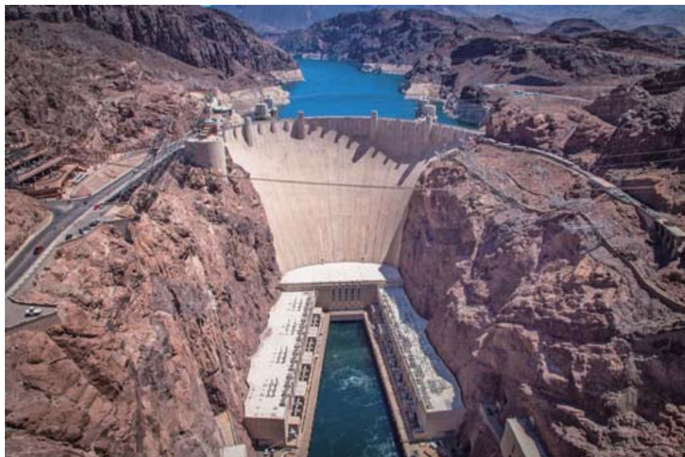
Φωτ. 4.13. Το φράγμα Hoover στον ποταμό Colorado στις ΗΠΑ έχει ύψος 218 m, μήκος στέφης 375 m και πλάτος στέφης 14 m. Κατασκευάστηκε το 1936 και στην εποχή του ήταν το μεγαλύτερο φράγμα στον κόσμο.
