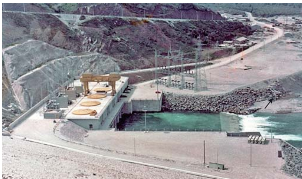
Φωτ. 1.4. Ο ΥΗΣ Πουρναρίου. Διακρίνονται τα κίτρινα καπάκια των γεννητριών και ο υποσταθμός με τη γραμμή μεταφοράς. Κάτω από το Σταθμό είναι η έξοδος των διωρύγων φυγής, που εκβάλλουν στην παλιά κοιτή του Άραχθου.
