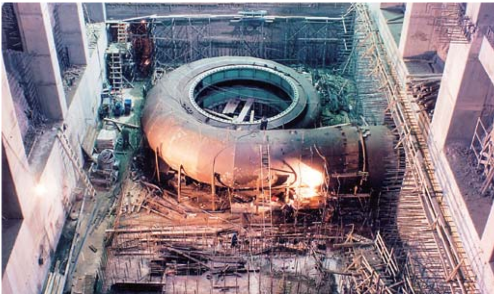
Φωτ. 6.3. Η εικόνα από τον υπόγειο ΥΗΣταθμό του Θησαυρού σε φάση συγκόλλησης των δαχτυλιδιών του σαλίγκαρου. Στο κέντρο του σαλίγκαρου θα τοποθετηθεί η τουρμπίνα και πάνω απ' αυτήν η γεννήτρια.
