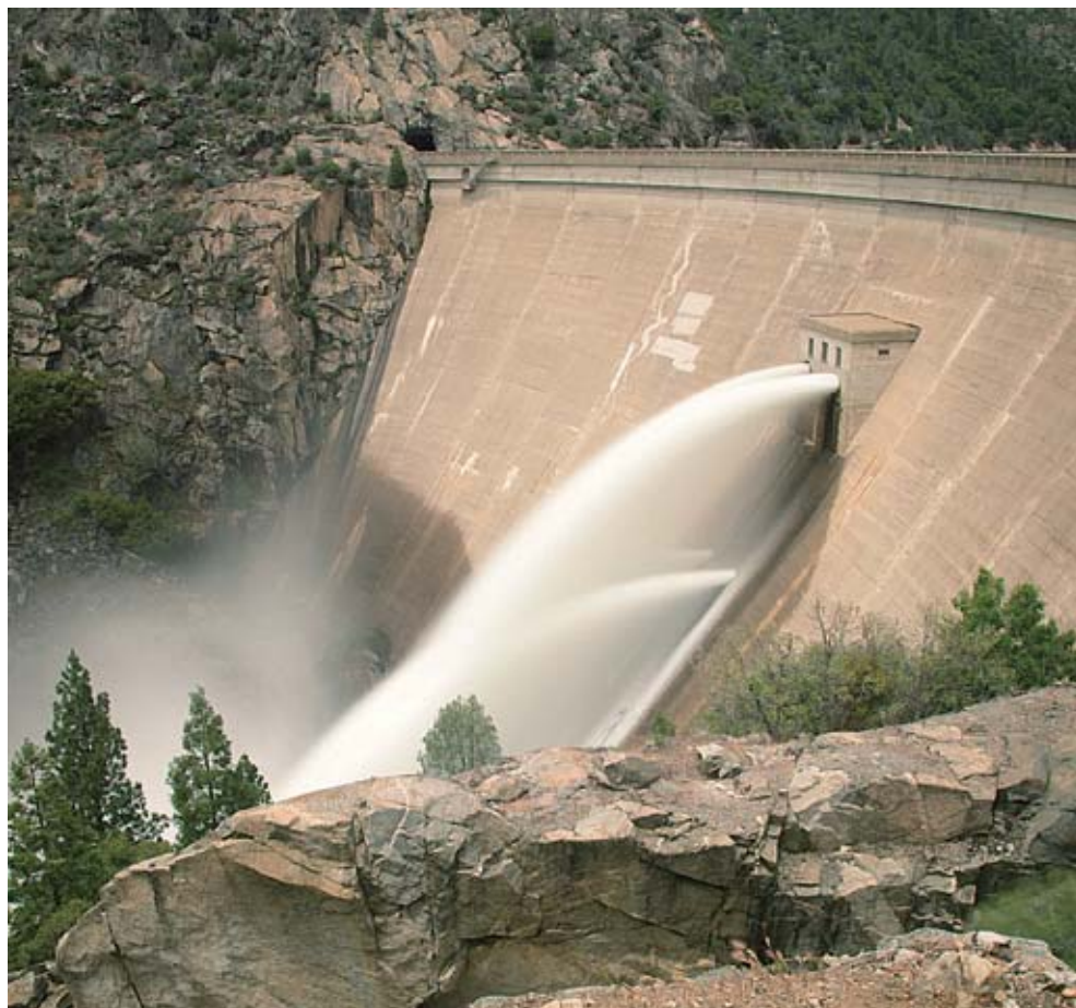
Φωτ. 6.1. Ο υπερχειλιστής τύπου οπής του φράγματος O' Shaugnessy.
