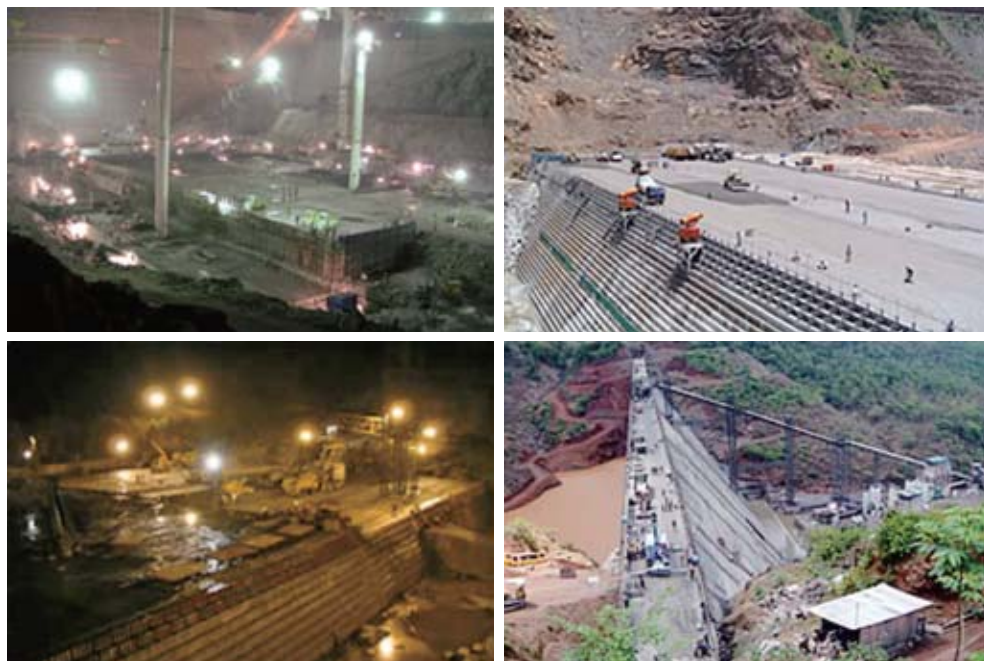
Φωτ. 7.12. Φάσεις κατασκευής φραγμάτων RCC σε διάφορες περιοχές. Στα θερμά κλίματα η διάστρωση γίνεται συνήθως τις νυχτερικές ώρες (αριστερά), ενώ (κάτω δεξιά) διαστρώνεται η τελευταία στρώση του φράγματος.
