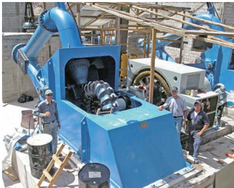
Φωτ. 6.8. Εγκατάσταση τουρμπίνας Pelton. Διακρίνεται το ένα ακροφύσιο, η τουρμπίνα με το διπλό περύγιο, και δεξιά η γεννήτρια στην επέκταση του άξονα της τουρμπίνας (ευγενής προσφορά εταιρίας Canyon Hydro).
