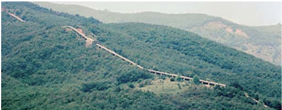
Φωτ. 1.11. Ο αγωγός προσαγωγής του νερού από τον ταμιευτήρα, στον ΥΗΣ Πλαστήρα στην Καρδίτσα.
