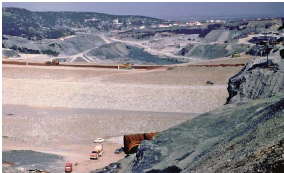
Φωτ. 5.5.43. Διάστρωση και συμπίκνωση του πυρήνα και των φίλτρων του φράγματος των Ασωμάτων. Έχει ήδη γίνει η μερική επένδυση του ανάντι πρανούς. Στο βάθος φαίνεται η ροή του ποταμού μετά την έξοδό του από τη σήραγγα εκτροπής.
