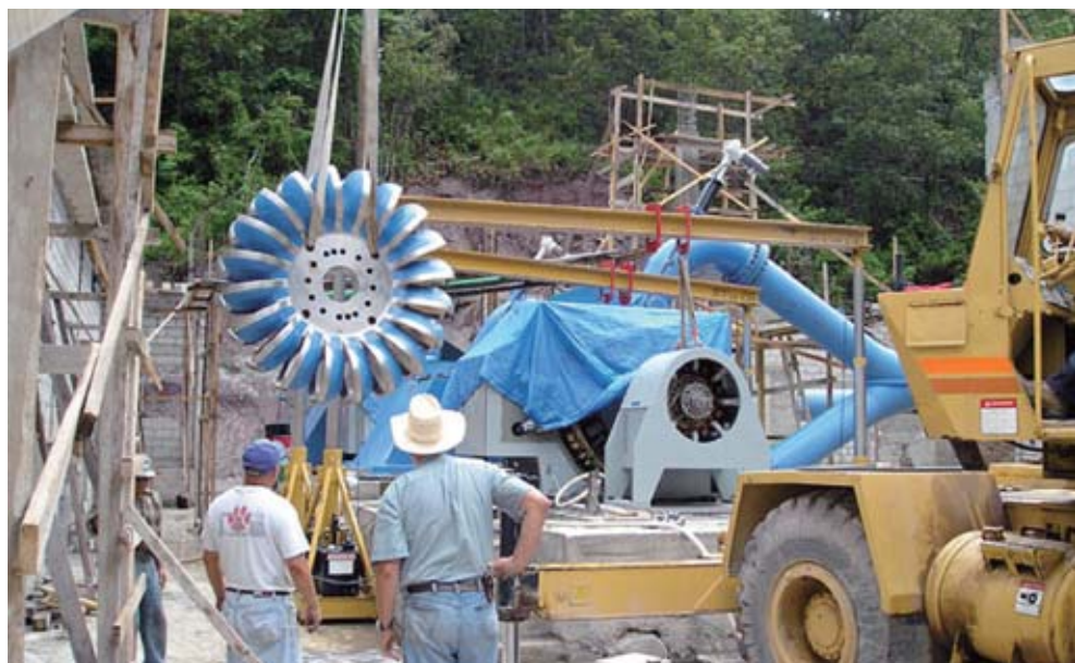
Φωτ. 6.7. Ο τροχός με τα περύγια μεταφέρεται στο έργο. Ήδη έχουν εγκατασταθεί οι αγωγοί και ο τροχός έρχεται να κουμπώσει στη θέση του.
