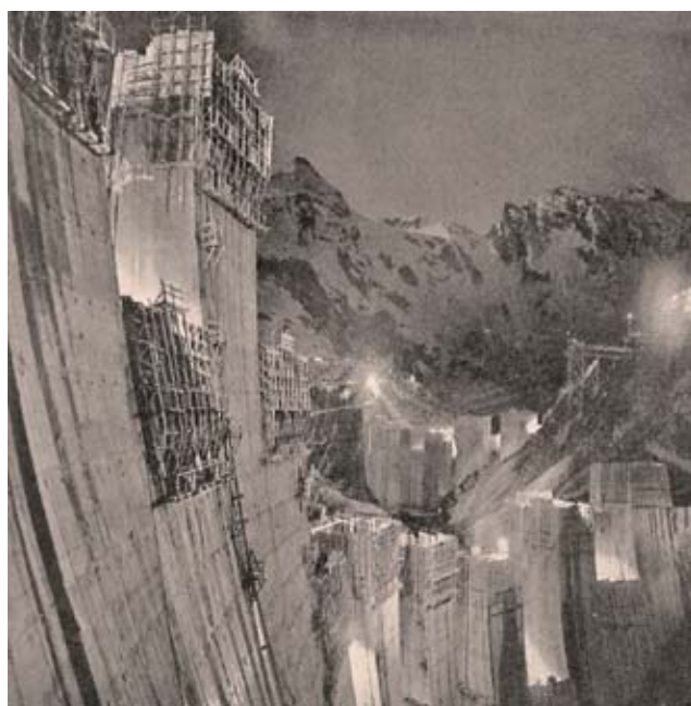
Φωτ. 4.13. Το φράγμα Hoover στον ποταμό Colorado στις ΗΠΑ έχει ύψος 218 m, μήκος στέφης 375 m και πλάτος στέφης 14 m. Κατασκευάστηκε το 1936 και στην εποχή του ήταν το μεγαλύτερο φράγμα στον κόσμο.
