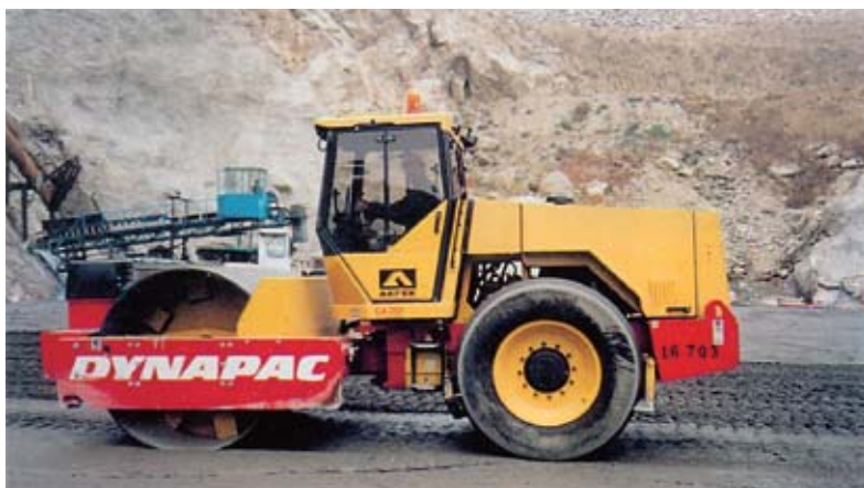
Φωτ. 7.10. Μεταφορά, διάστρωση και συμπίκνωση του RCC στο φράγμα της Πλατανόβρυσης (Α. Κραβαρίτη, Υ-Ε Πλατανόβρυσης, ΔΕΗ, Ιούλιος 1998).
