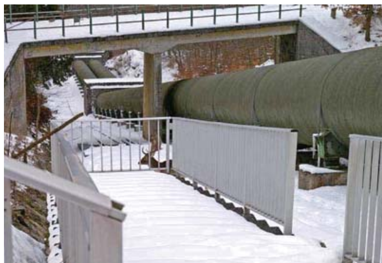
Φωτ. 1.10. Η προσαγωγή του νερού από το μεριστή στις τουρμπίνες γίνεται με χαλύβδινους σωλήνες μεγάλης διαμέτρου.
