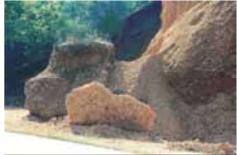
Εικόνα 1.4.2: Κατολισθήση στην περιοχή των Ιωαννίνων
