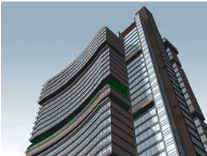
Άποψη ενός ουρανοξύστη από το έδαφος. View a skyscraper from the ground.
