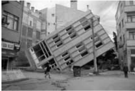
Σχήμα 1.38: Τυπική αστοχία επιφανειακής θεμελίωσης σε συνδυασμό με μερική ρευστοποίηση (Σεισμός Kocaeli, 17/08/1999, M_w = 7.4 ).
