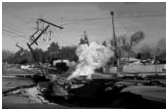
Σχήμα 1.26: Αστοχίες σε δίκτυα κοινής ωφέλειας και έμμεσου τύπου ζημιές και απώλειες (Σεισμός Northridge, 1994).
