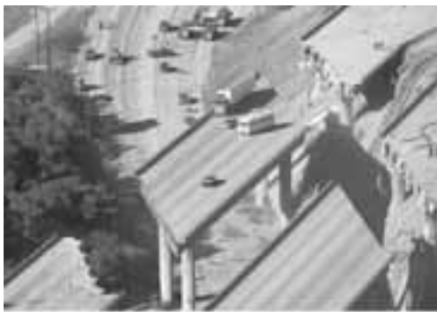
Σχήμα 1.21: Κατάρρευση καταστρώματος γέφυρας - Ανεπάρκεια πλάτους εφεδράνου (Σεισμός Northridge, 1994).
