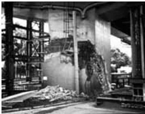
Σχήμα 1.12: Διατμητική αστοχία ορθογωνικού βάρου (Σεισμός Kobe, 1995).
