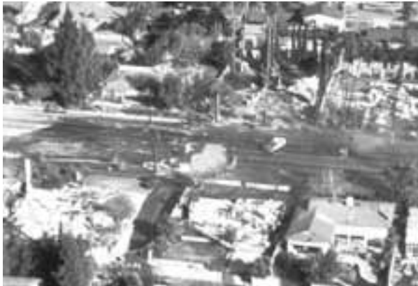
Σχήμα 1.25: Πανοραμική φωτογραφία της λεωφόρου Balboa στην περιοχή Granada Hills - Δρόμος πλημμυρισμένος λόγω αστοχίας από εφελκυσμό αγωγών ύδρευσης - Ταυτόχρονη αστοχία και αγωγών φυσικού αερίου προκάλεσαν εκτεταμένες φωτιές στις παρακείμενες κατοικίες, οι οποίες ήταν αδύνατο να σβήσουν λόγω αστοχίας του δικτύου ύδρευσης – πυρόσβεσης (L.A. Times Photo) (Σεισμός Northridge, 1994). Πρόκειται για μια από τις χαρακτηριστικότερες περιπτώσεις έμμεσων ζημιών.
