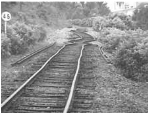
Σχήμα 1.37: Κάμψη και μόνιμες παραμορφώσεις σιδηροδρομικής γραμμής λόγω δευτερογενούς επιφανειακής διάρρηξης ρήγματος (Σεισμός Chi-Chi, 21/09/1999, M_s = 7.6 ).
