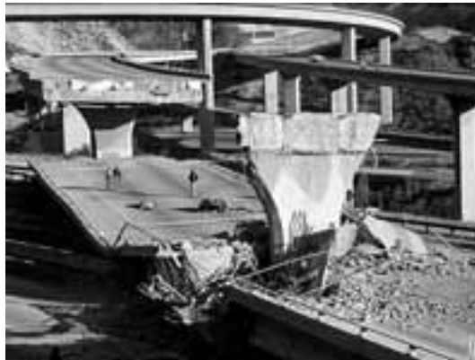
Σχήμα 1.21: Κατάρρευση καταστρώματος γέφυρας - Ανεπάρκεια πλάτους εφεδράνου (Σεισμός Northridge, 1994).
