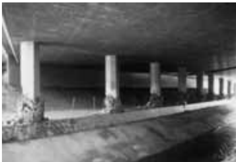
Σχήμα 1.22: Κατάρρευση καταστρώματος γέφυρας (Σεισμός Northridge, 1994).
