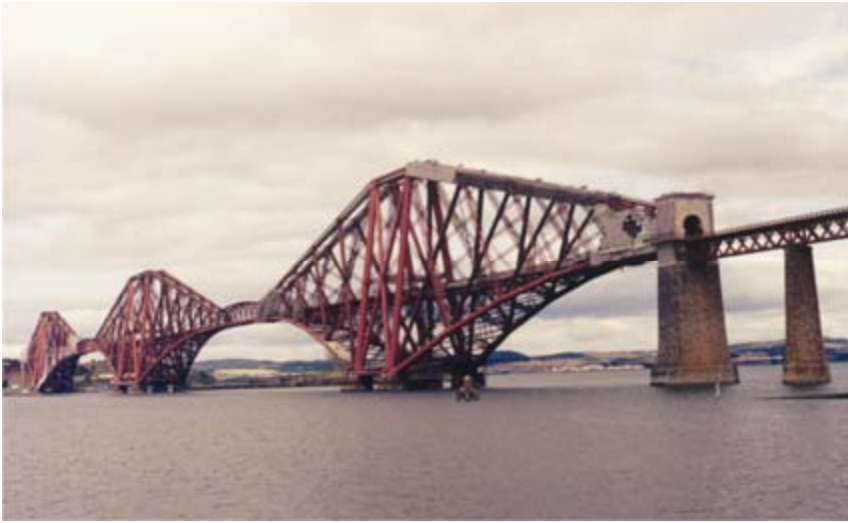
Σχήμα 1.5.1: Η γέφυρα Firth of Forth στη Μεγάλη Βρετανία
