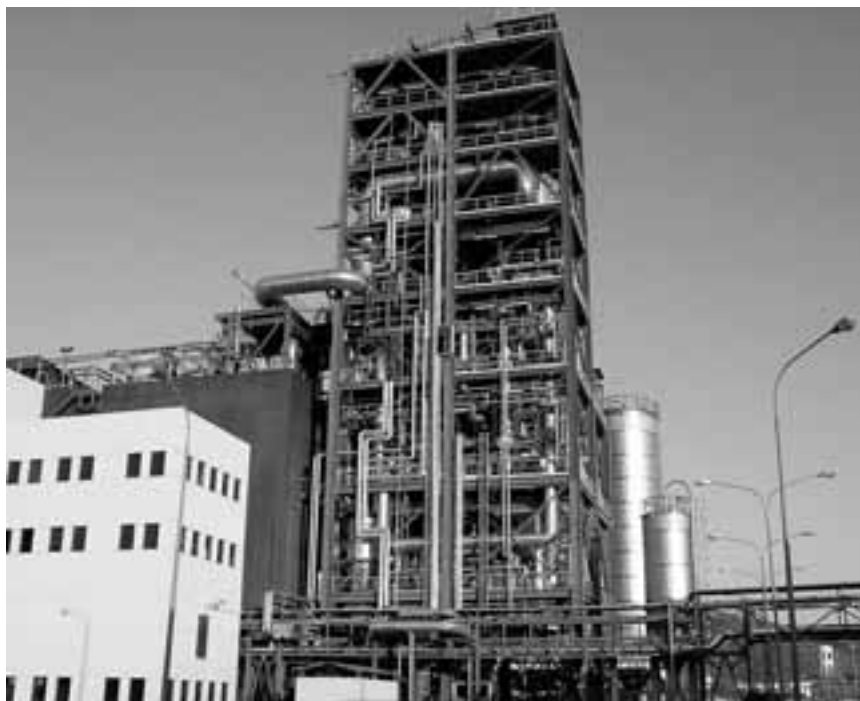
Εικόνα 1.3.1. Αντιδραστήρας παραγωγής PET στην Artenius Hellas (ΒΙΠΕ Βόλου) με πολυσυμπύκνωση στερεάς κατάστασης.
